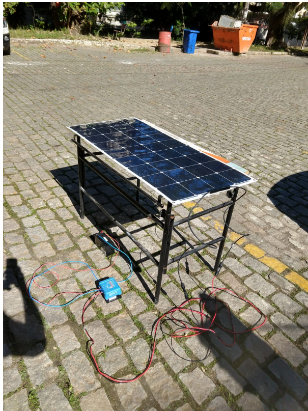
Figura 5.4: Teste dos módulos fotovoltaicos
