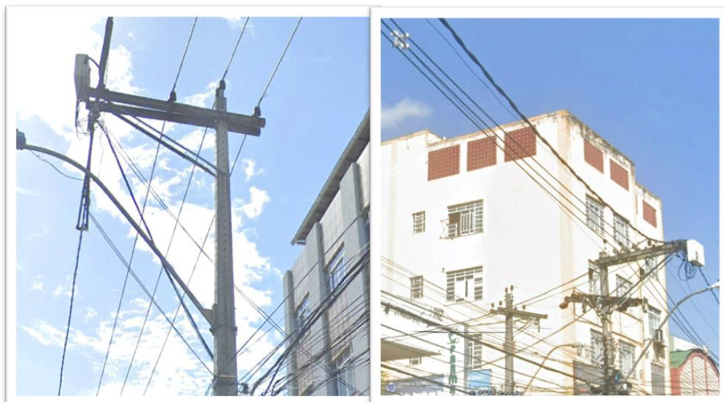
Figura 20: A esquerda há um exemplo de rede convencional localizada no circuito GAB05 e a direita um exemplo de rede compacta localiza em GAB13. Ambas são imagens do Google Earth de 2022.
