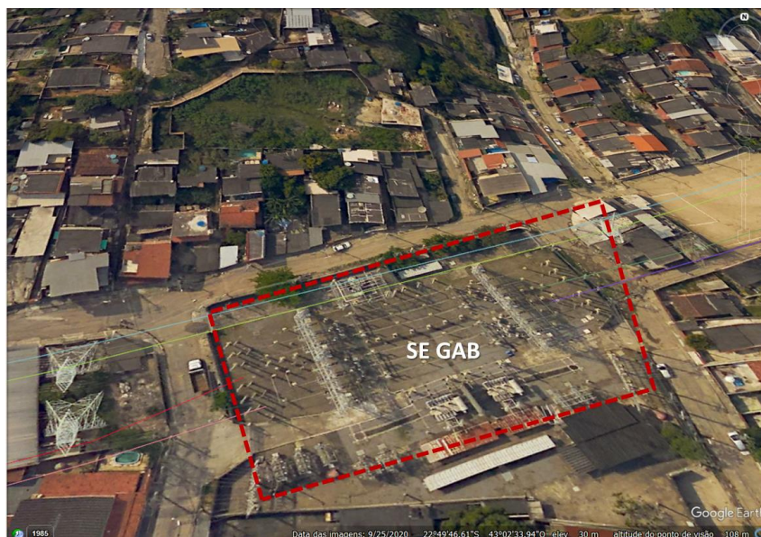
Figura 15: Vista superior da SE GAB, no google Earth 2022 com coordenadas.
