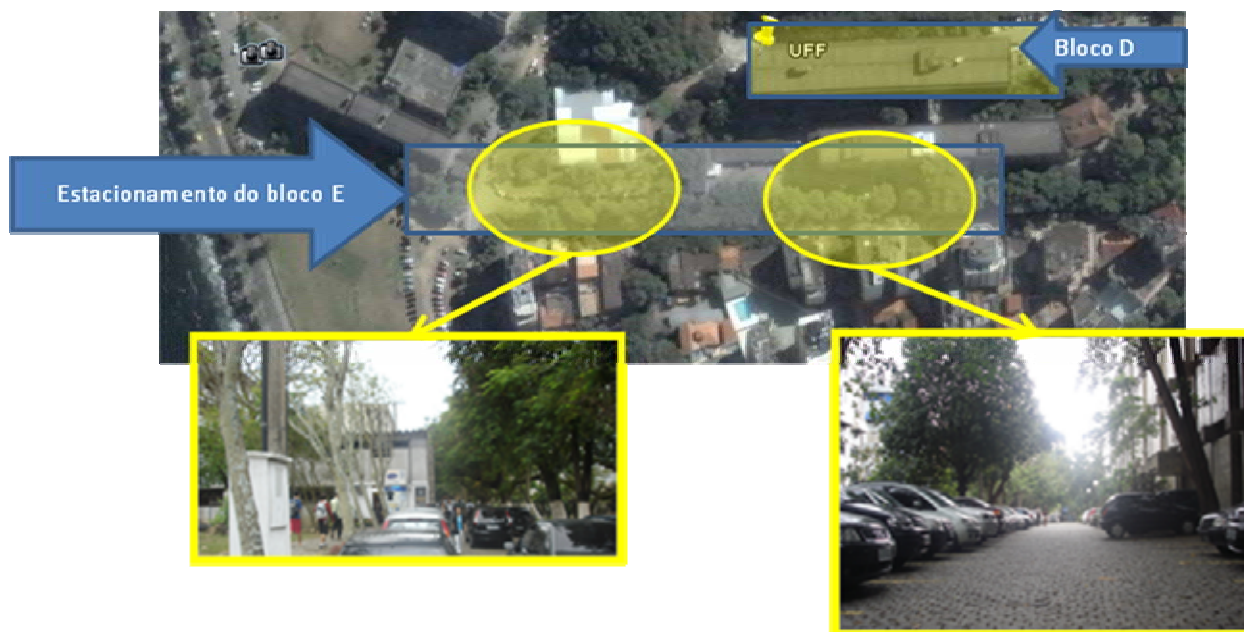
Figura 5.8 - Vista aérea dos blocos D e E do Campus Praia Vermelha, da UFF
