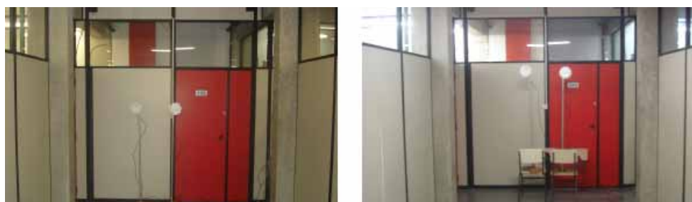
Figura 5.7 - Antenas de recepção posicionadas no quarto andar do bloco D do Campus Praia Vermelha da UFF
