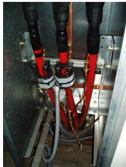
b) Instalação do acoplador
